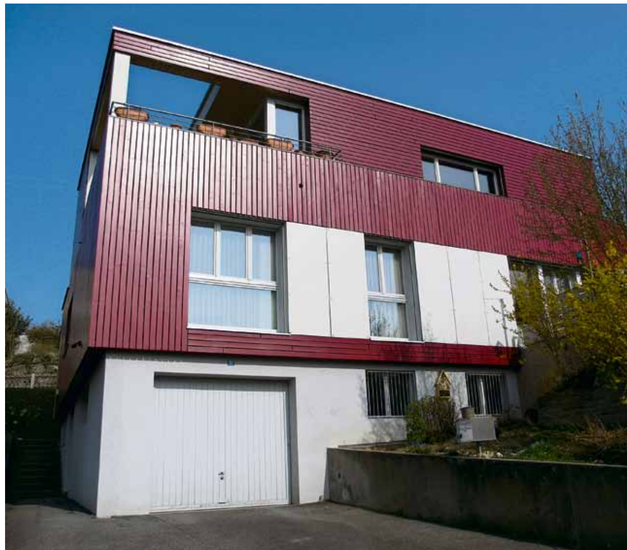
Der Aufbau, die Fassade und optimal ausgenutzte Platzverhältnisse zeichnen den Umbau aus.
