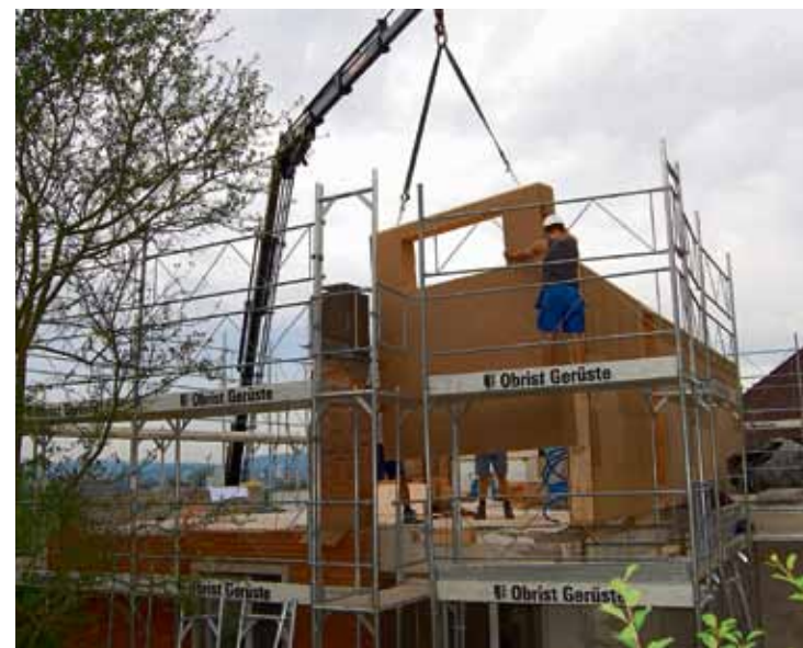
Der Aufbau entstand aus vorgefertigten Holzelementen.
