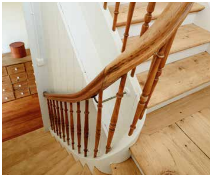
Mit Sorgfalt wurde die Treppenanlage renoviert.
