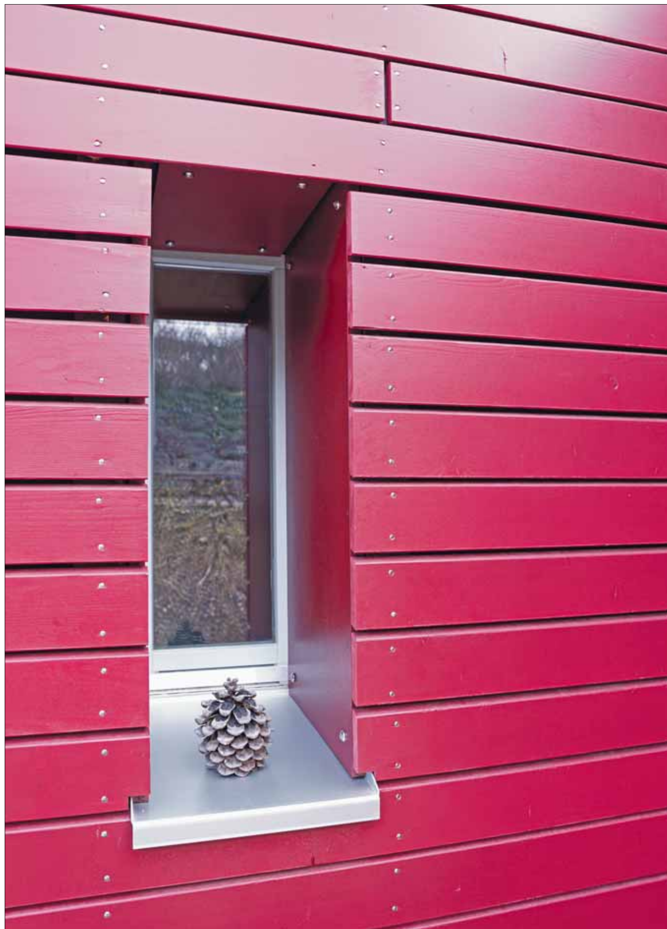
Bei diesem kleinen Fenster auf der Nordseite ist die beeindruckende Dicke der neuen Gebäudehülle gut sichtbar.
